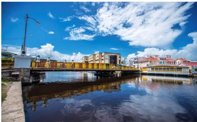
**旋轉橋**：建於1922年，這是目前世界上唯一一座仍為人力操作的橋樑。旋轉橋連接連接城市的南北兩側，此地乃該市最熱鬧區域的中心。旋轉橋設計為可以左右旋轉，若有船隻通過，只要旋轉橋面即可。
