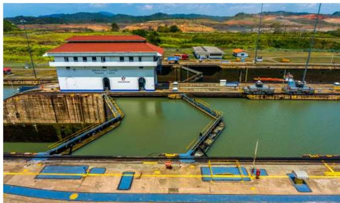
**米拉弗洛雷斯船閘**：位於太平洋岸上的兩段式閘門，船隻通過運河水閘門緩緩移動的操作情形。但由於太平洋海面比大西洋海面高 24 公分，並
