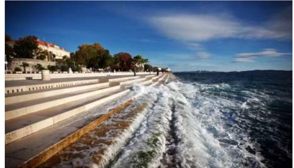
**海管風琴：**海岸邊海管風琴藉由海浪拍打和空氣的推在海岸邊建了七十公尺規則排列的石階，石階底下埋了35根不同直徑和長度的管子，隨著流動、擠壓以及海浪的拍打，空氣湧入管子，也就是說海浪就是風箱。當海水漲到適合的水位，大海就會演出奇妙的樂音。海風琴可以演奏五個八度的七和弦，發出如同管風琴般共鳴的美妙音色，精心設計的海管風琴成為這個海邊城市的特色
